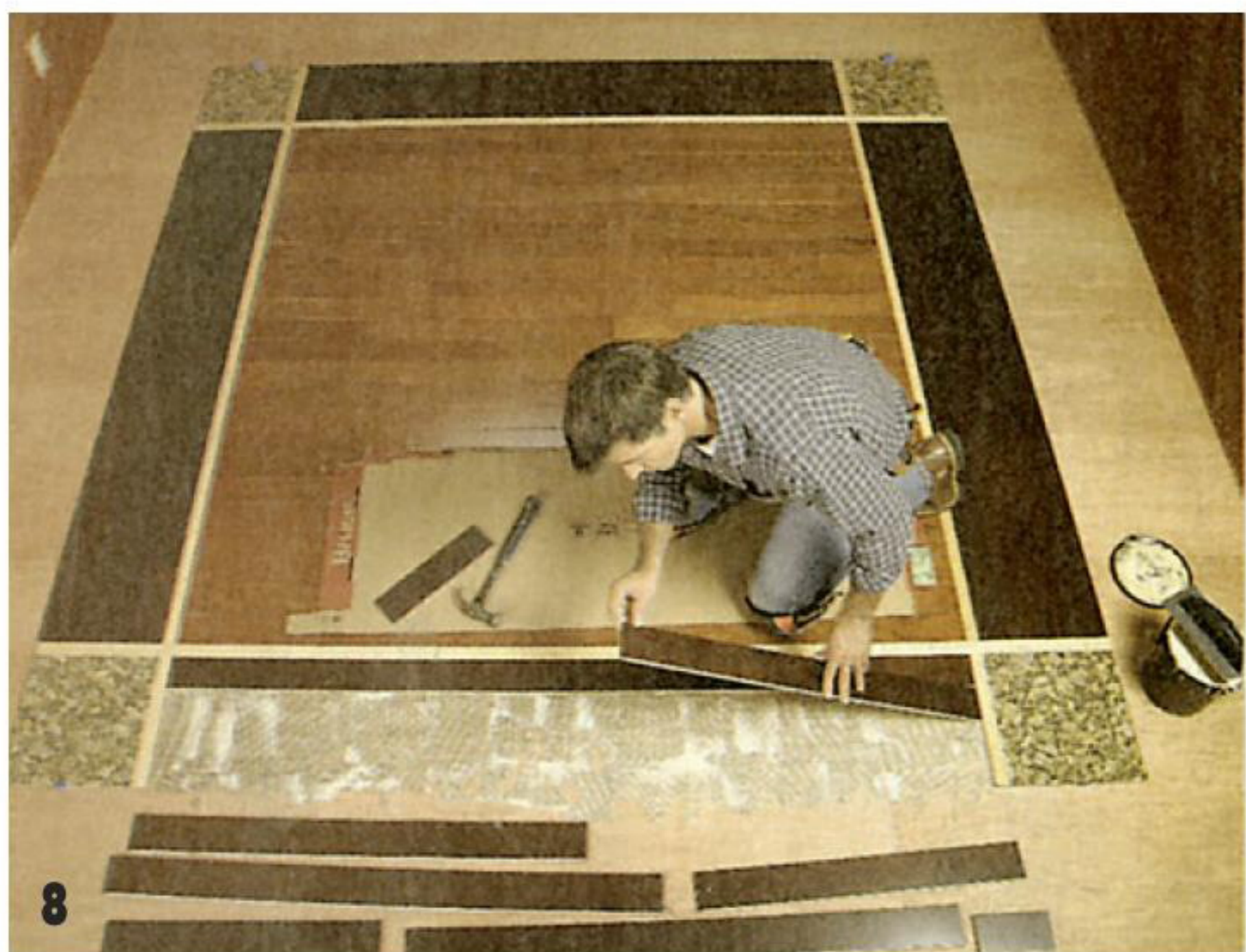
Приклеивают к основе короткие акцентирующие планки. «Ушки» из самоклеящейся ленты на плитах позволят потом легко извлечь их, чтобы вклеить окончательно только в конце работы.
