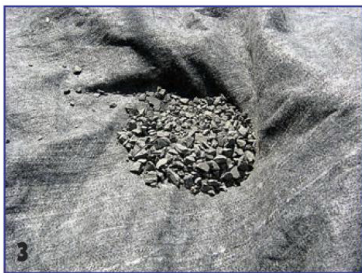
Для устройства донного фильтра использовали водопроницаемый геотекстиль и шунгитовый щебень.
