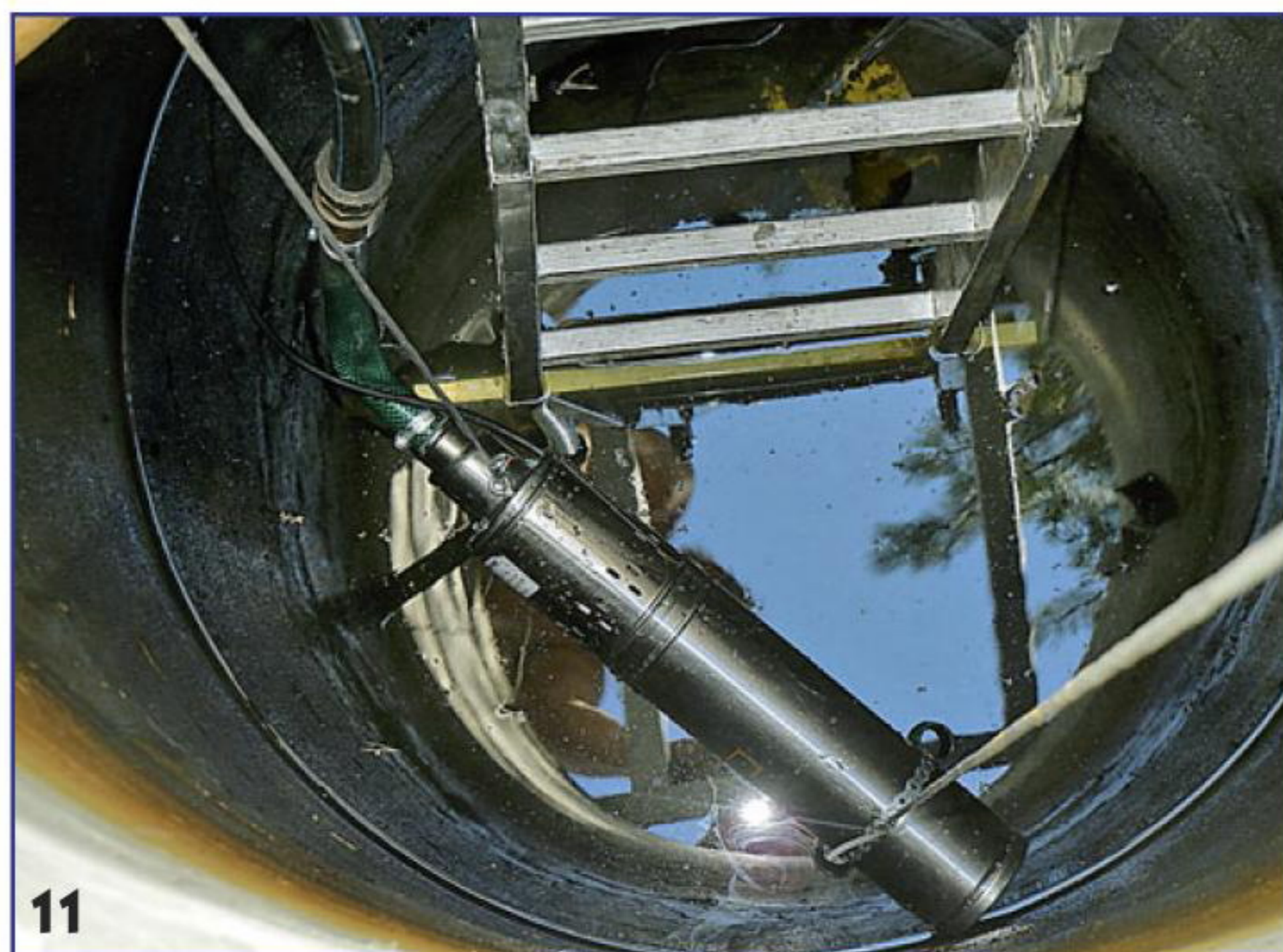
11 В нашем неглубоком колодце насос решено было установить в горизонтальном положении.
