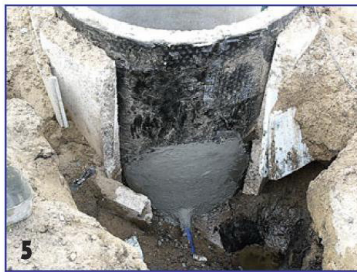
...которые зашпатлевали быстротвердеющими цементными составами.
