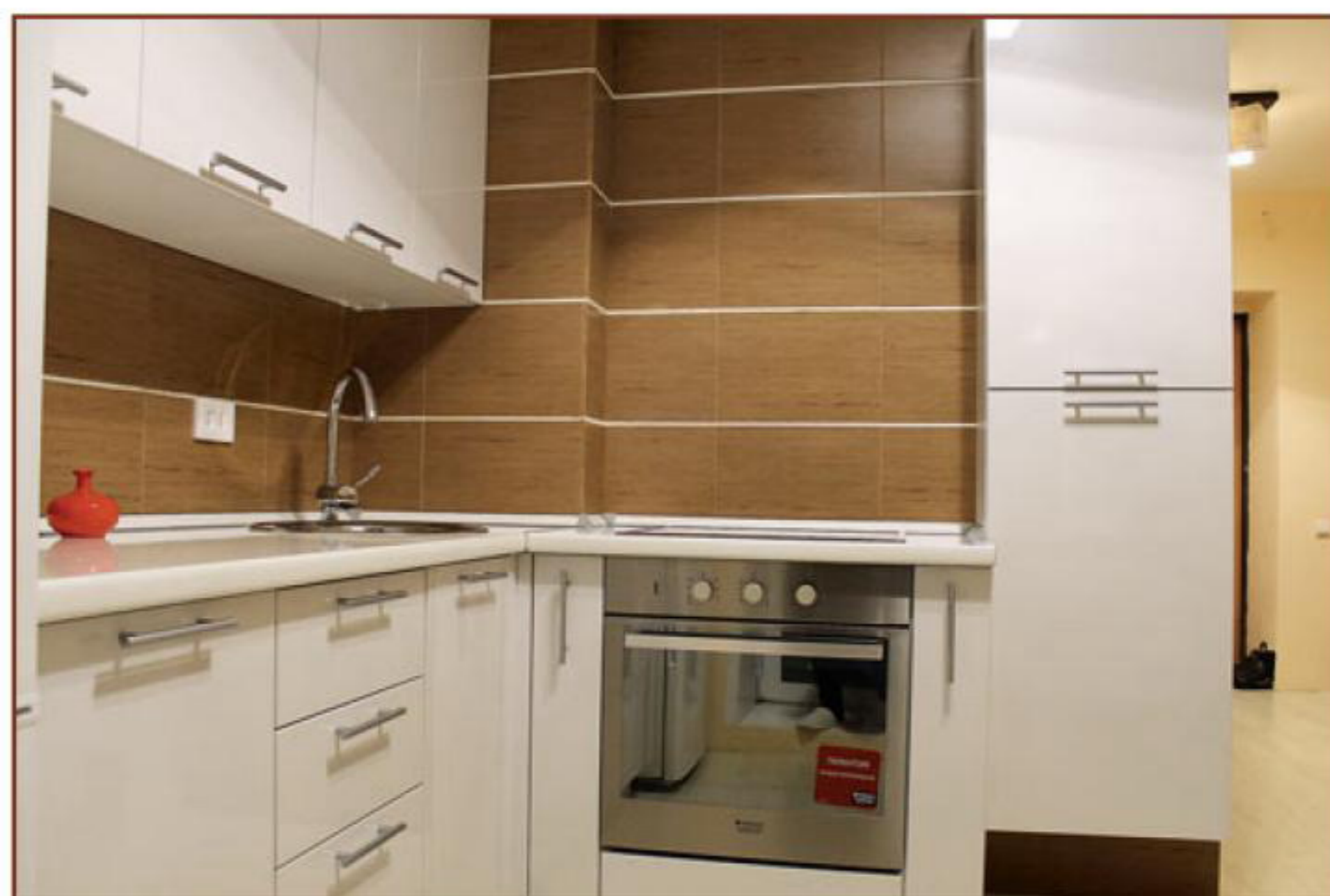
При облицовке стены керамической плиткой над рабочей поверхностью мы стремились горизонтальные швы сделать максимально широкими, выделив их светло-молочной затиркой, а узенькие вертикальные скрыть затиркой в цвет плитки.
