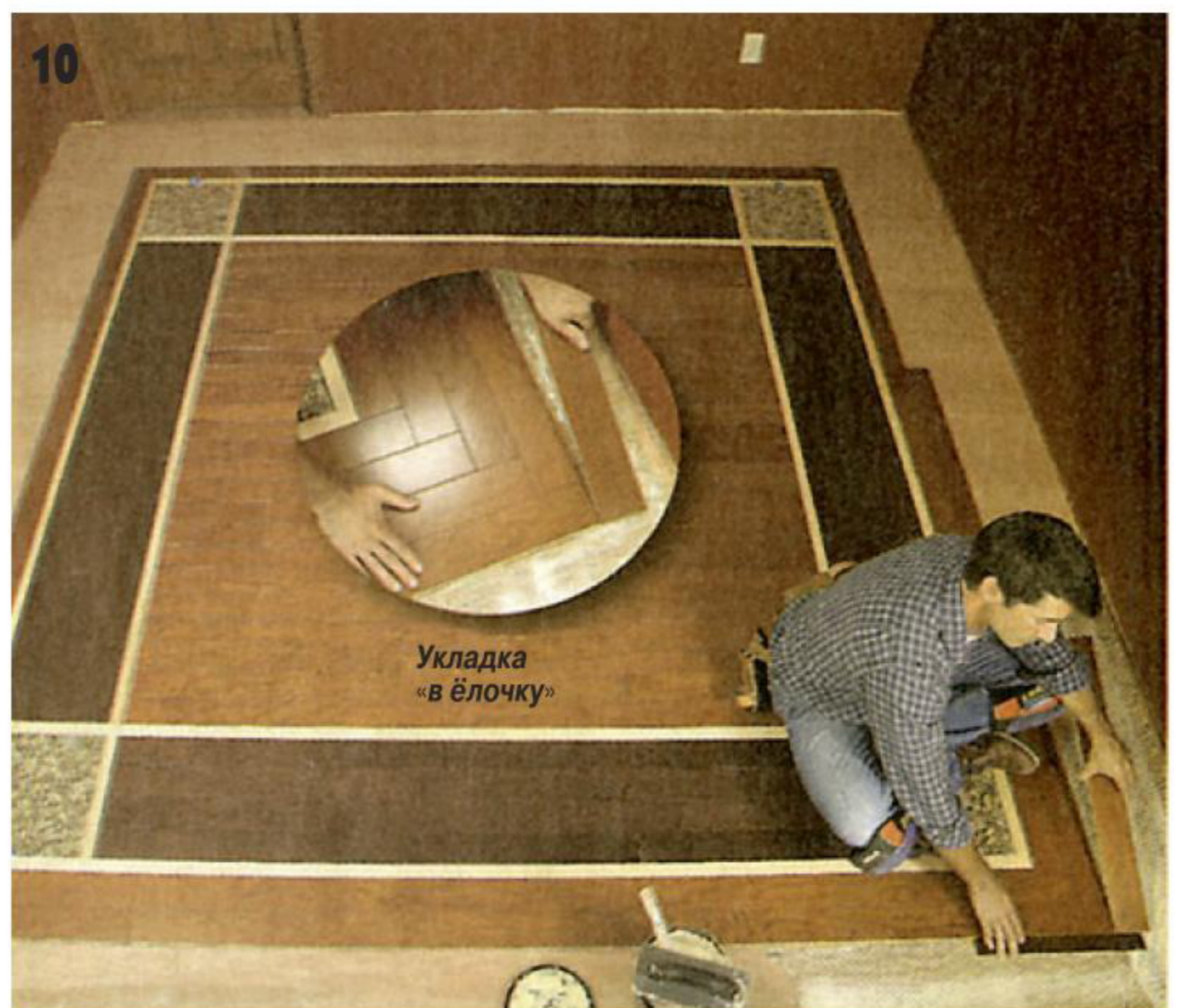
Доски наружного обрамления в углах укладывают «в ёлочку». Если нужно, крайние доски по периметру опиливают по ширине.
