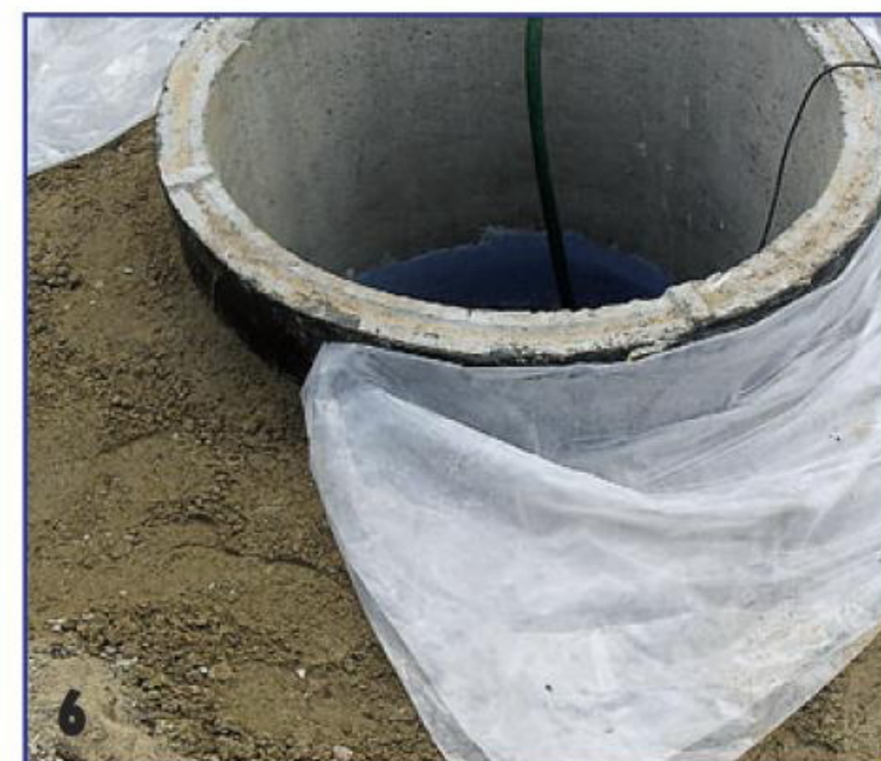
Верх колодца обернули двумя слоями полиэтиленовой плёнки...
