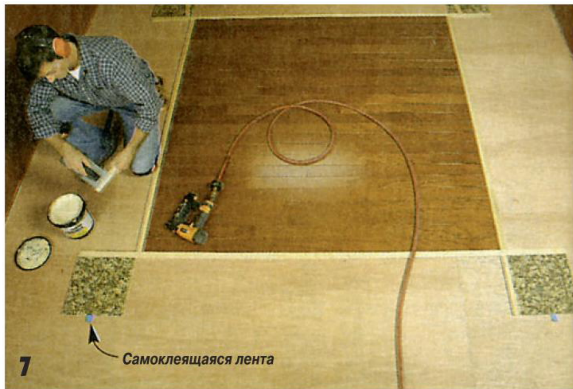
Приклеивают к основе короткие акцентирующие планки. «Ушки» из самоклеящейся ленты на плитах позволят потом легко извлечь их, чтобы вклеить окончательно только в конце работы.
