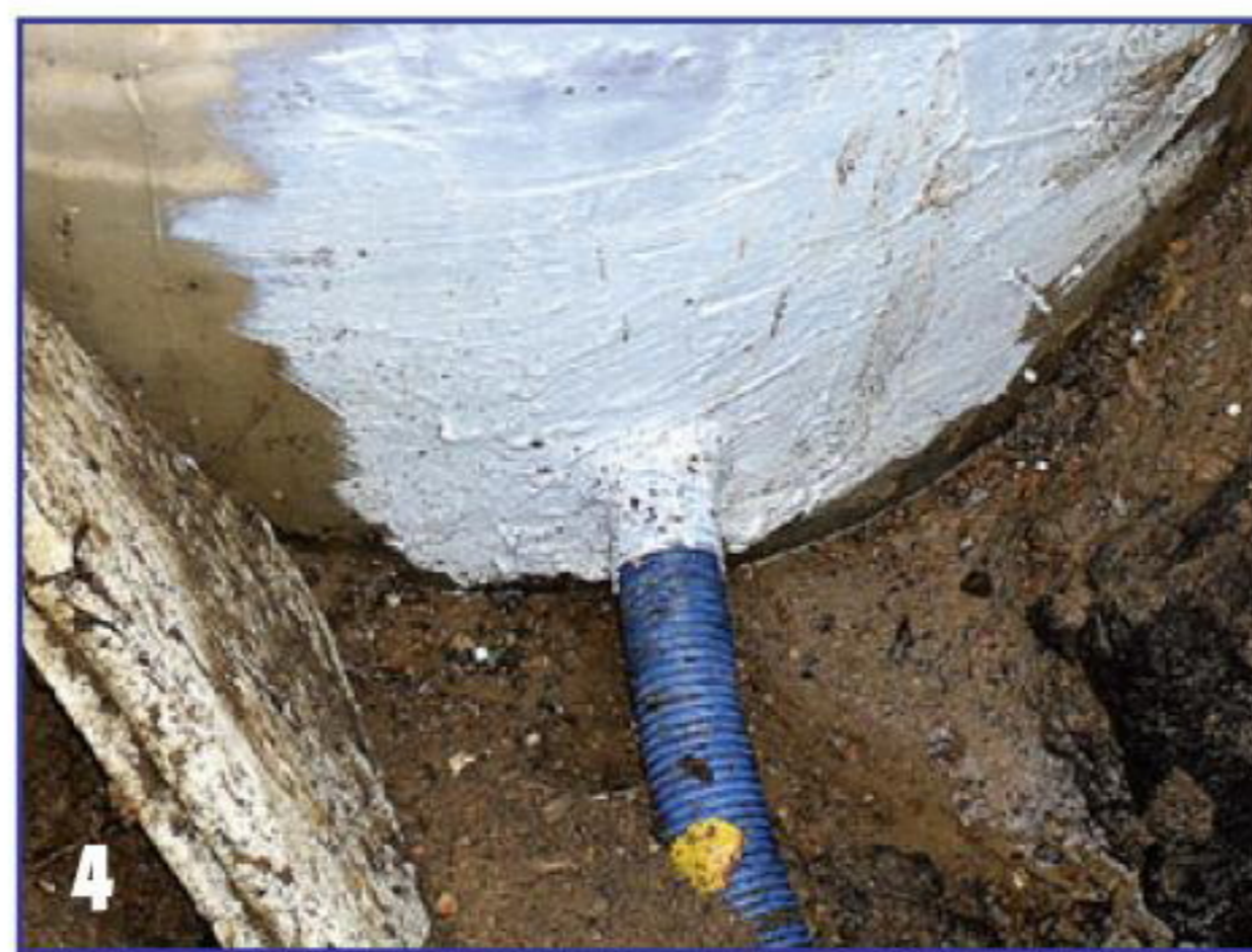
Место прохода трубы сквозь бетонное кольцо герметизировали несколькими слоями фиброрезины...
