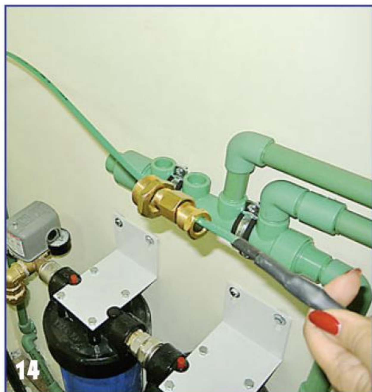
...заправляется внутрь водопроводной трубы.
