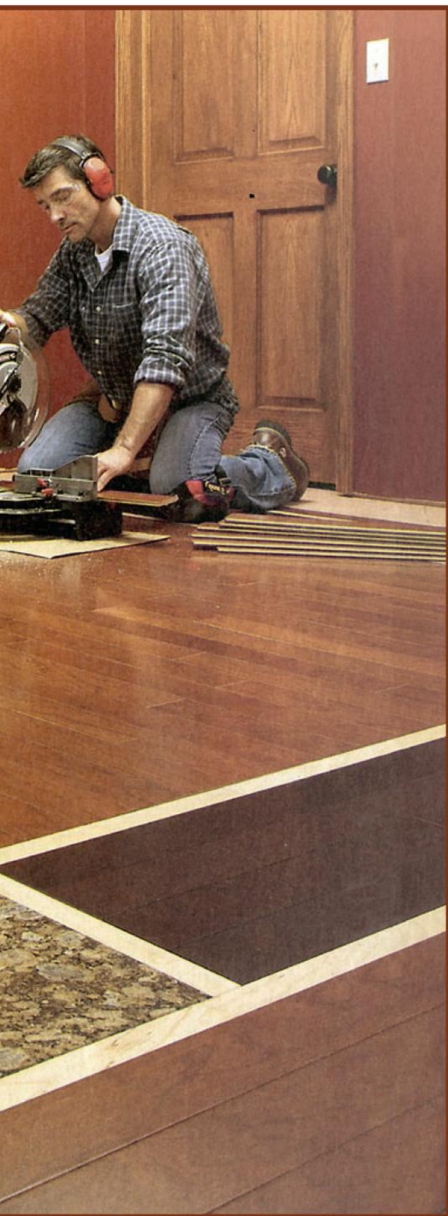
Короткие детали напольного покрытия и две плиты укладывают от одной стены до противоположной. Цель — подобрать такую ширину обрамления, чтобы поле можно было застелить досками, не раскраивая их по ширине.
