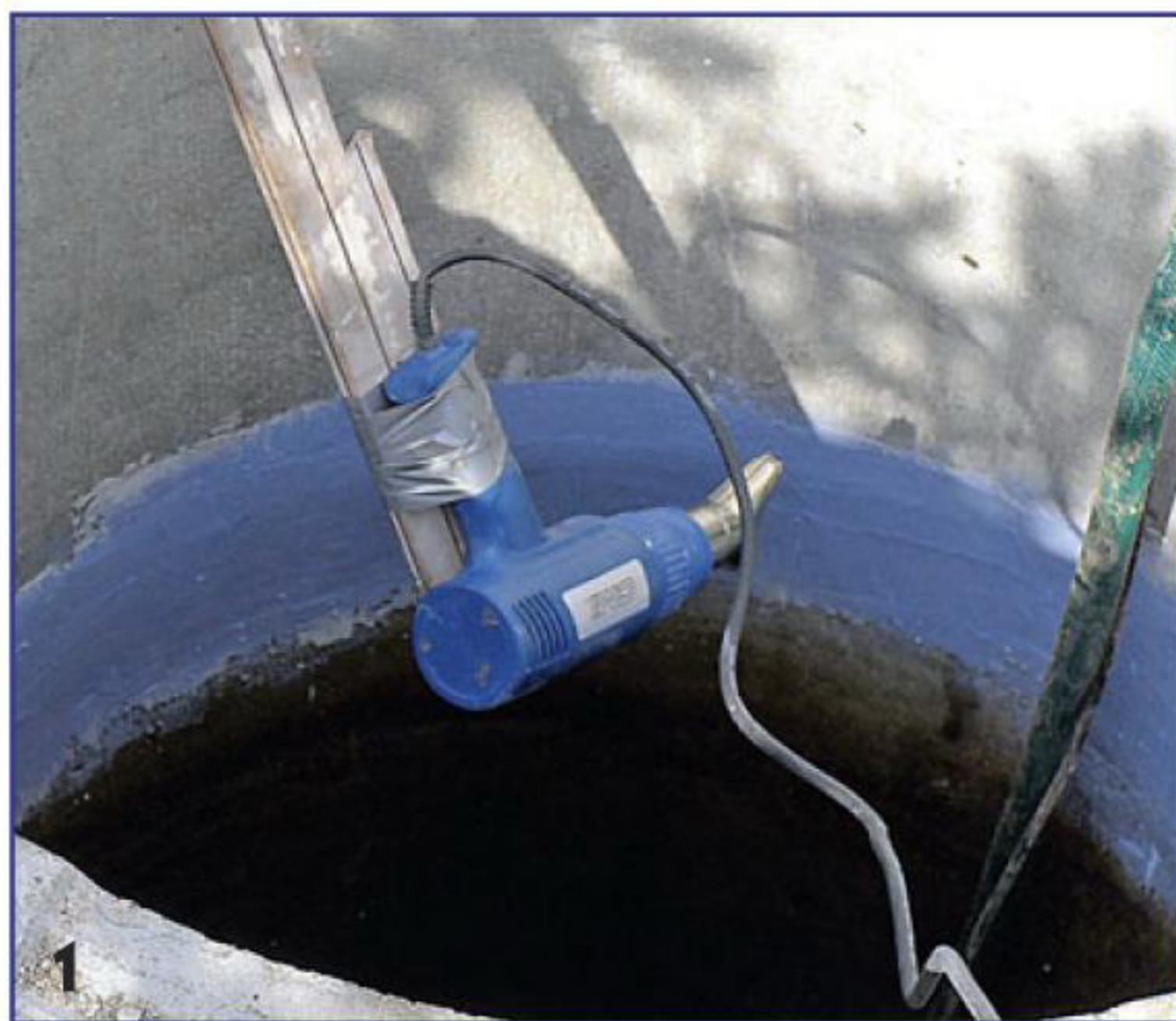
Заполненные швы между кольцами колодца дополнительно герметизировали фиброрезиной.
