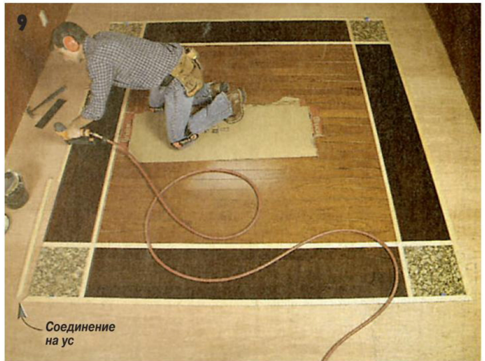
Запиленные на ус концы внешних акцентирующих планок стыкуют в углах. Планки стыкуют с крайними досками бордюра, используя штатные пазы и шипы.
