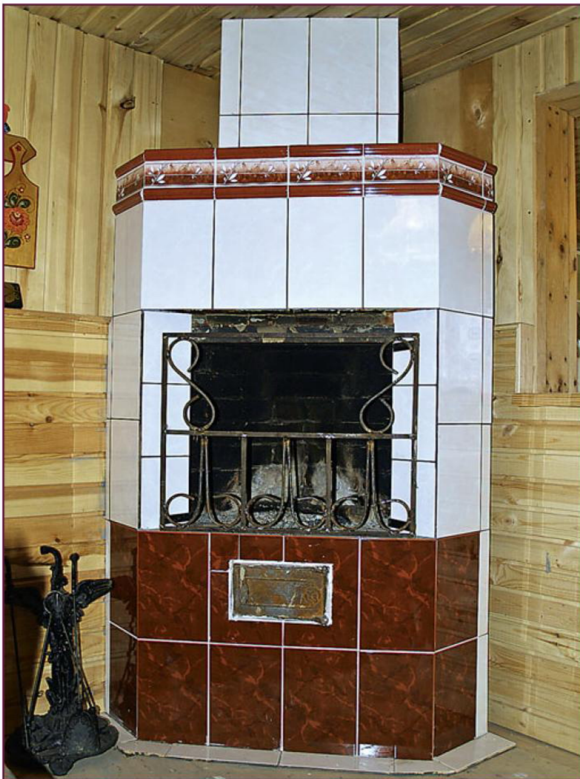
Камин и труба облицованы кафельной плиткой.
