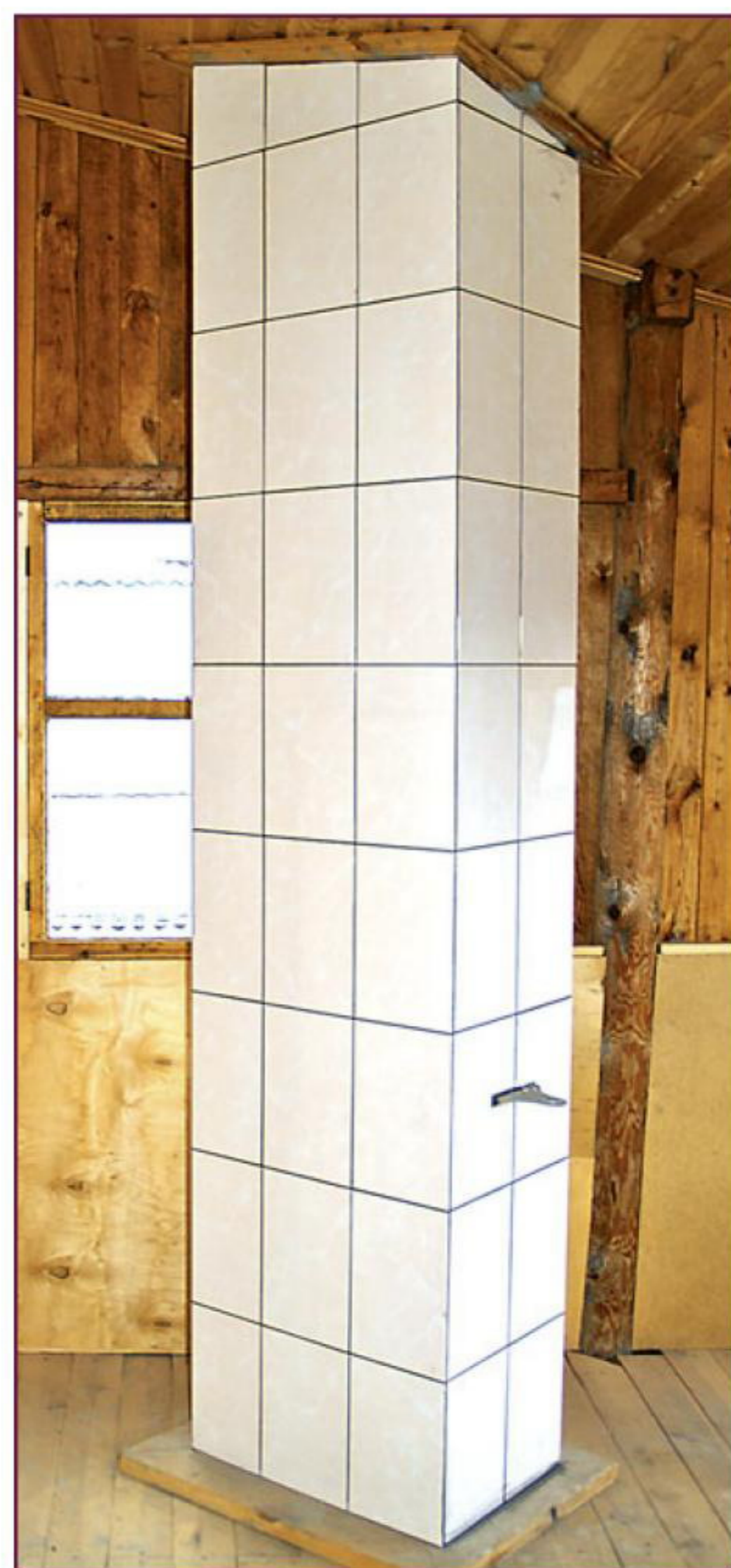
Камин и труба облицованы кафельной плиткой.
