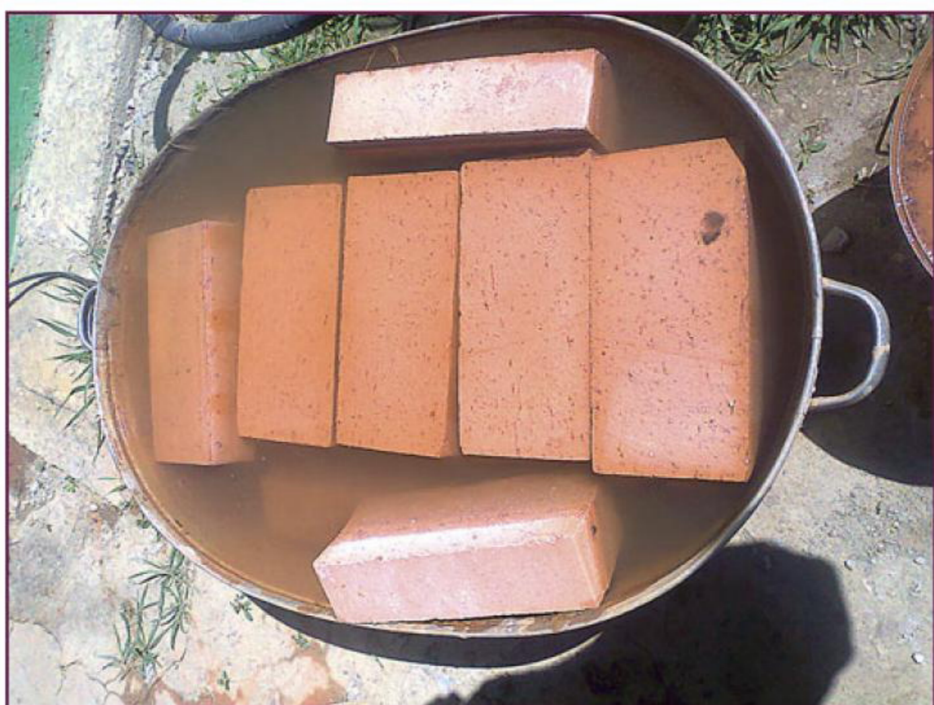
Кирпичи перед кладкой вымачивал в воде.
