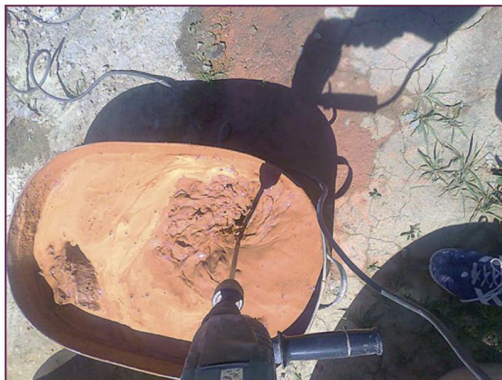
Размокшую глину перемешивал миксерной насадкой до равномерной консистенции.
